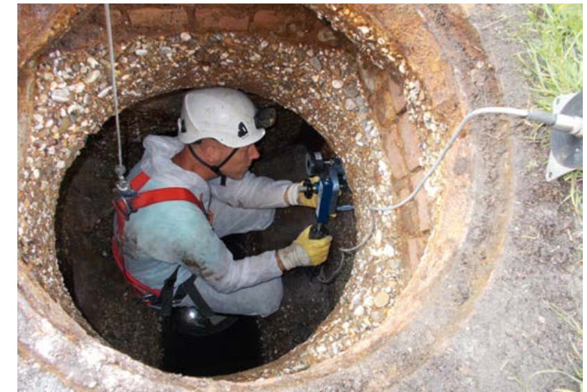
Onderzoekswerk in een rioolput.
