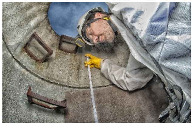
Onderzoek bij putrenovatie
