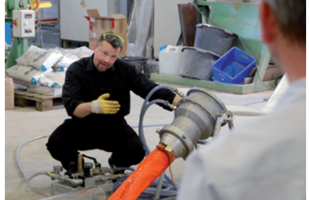
Rioolrenovatie met CIPP-liners
