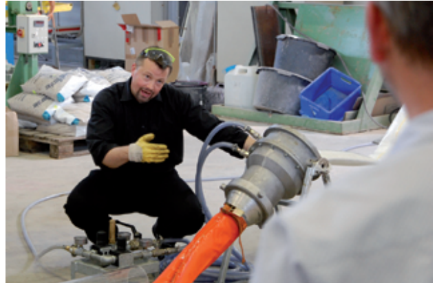
Rioolrenovatie met CIPP-liners
