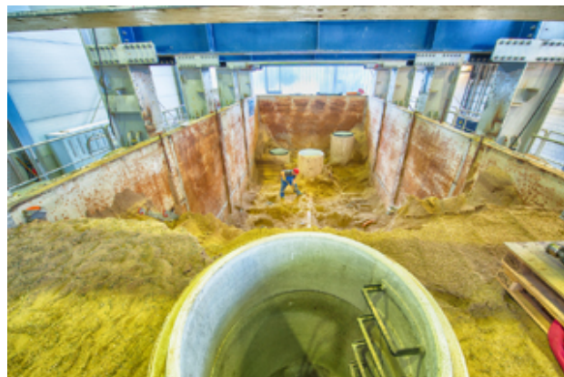
Inspectieputten in de 6 m diepe proefopstelling
